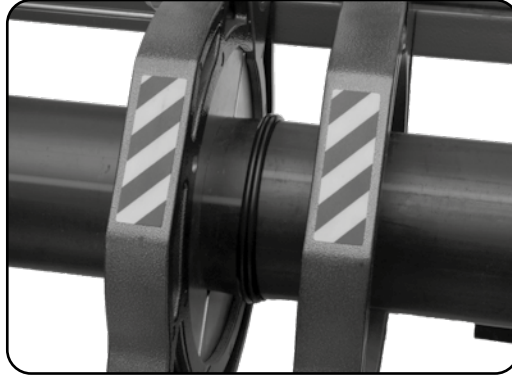
Şekil 5: Basınçlı ısıtma sonrasında ısıtıcının çekilip, boruların ağız ağıza getirilmesi (sol) ve basınç altında birleştirilmesi (sağ)
